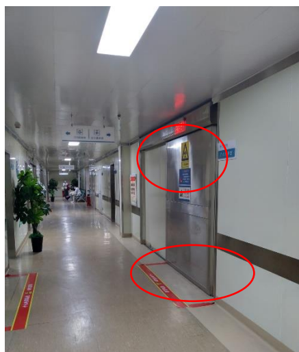
图 4-16 本项目 DSA 介入手术室当心电离辐射警示标志及地面警戒线
