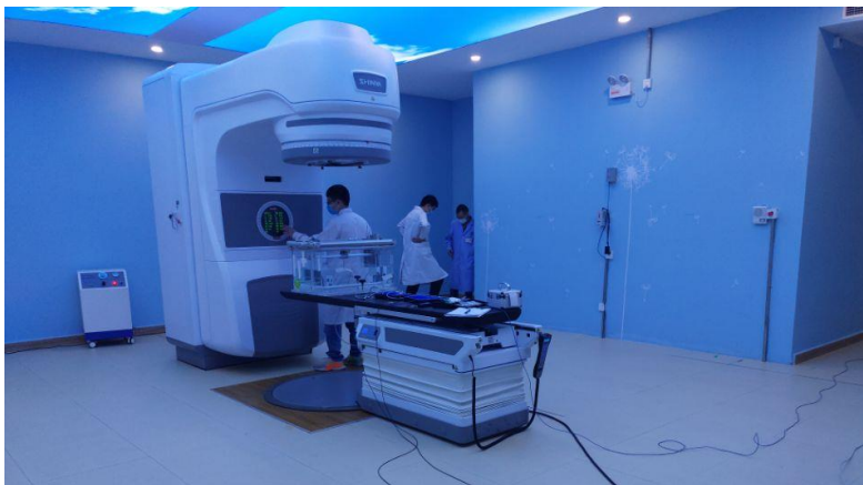
图 3-7 本项目医用电子直线加速器设备
